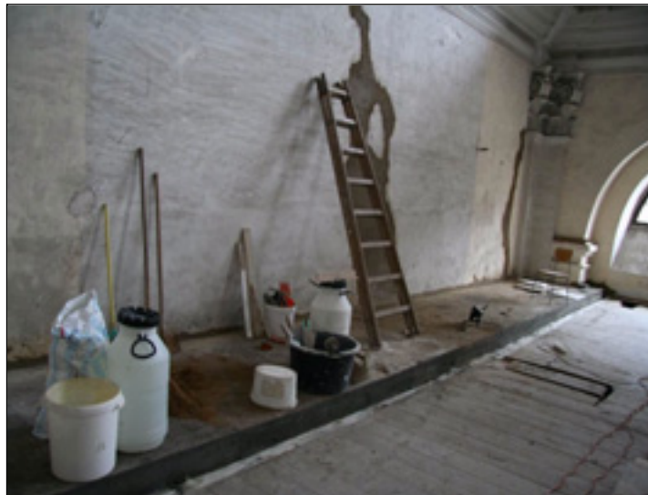
Rekonstrukce před dokončením foto J.Ševčík
