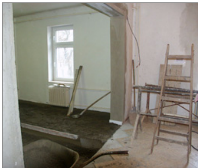
V prostorách AD se finišuje: podlahy, dveře... foto iv
