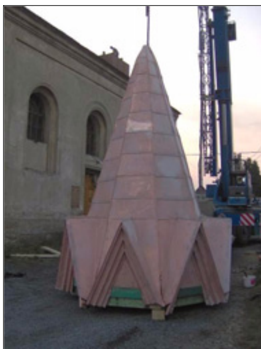
Nová věž na jeřábu foto V. Doubek
