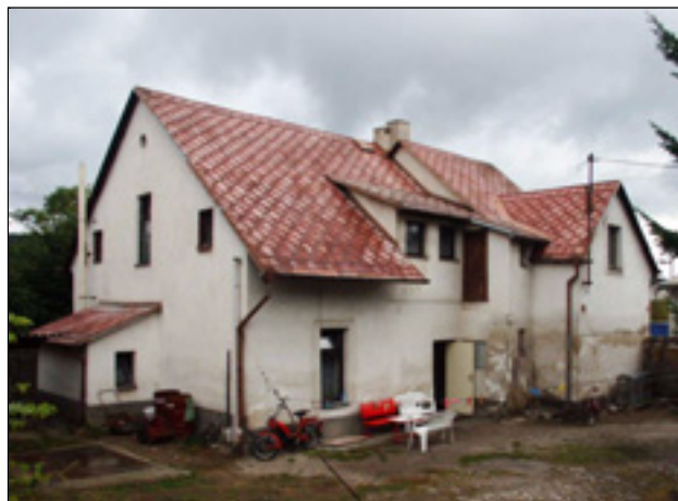
Azylový dům před rekonstrukcí. foto av
